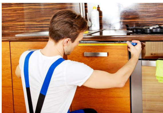
Figur 5: Opmåling af et køkken kræver at man anvender en fælles reference.
