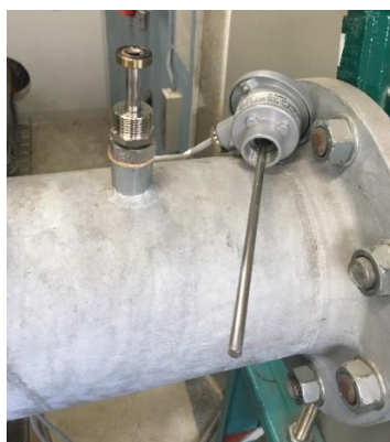
Figur 16 Til venstre PT100 monteret i et rør. Midt: PT100 sensoren udtaget af følerløbet (bemærk samlemetoden). Til højre vises en PT500 sensor med blødt kabel, som også kan findes anvendt som moteret til venstre.
