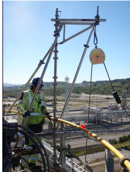
Figur 28 Måling med pitotrør en sommerdag højt oppe i en skorsten. Pil angiver pitotrøret.
