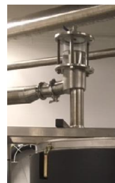
Figur 24 Knivrør. En skarp kant sikrer at væskens niveau før og efter er præcist den samme = mængden af væske igennem måleren er også mængden af væske løbet ned i tanken. Til højre et billede af en fysisk knivrør.
