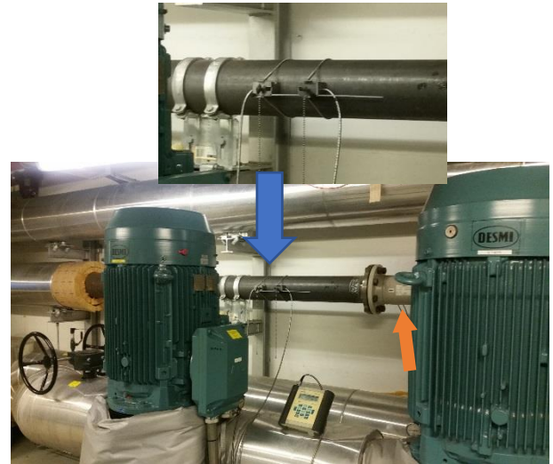
Figur 21 Måling med clamp-on udstyr på vandrør. (Kilde: NORFORS).
