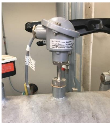
Figur 16 Til venstre PT100 monteret i et rør. Midt: PT100 sensoren udtaget af følerløbet (bemærk samlemetoden). Til højre vises en PT500 sensor med blødt kabel, som også kan findes anvendt som moteret til venstre.
