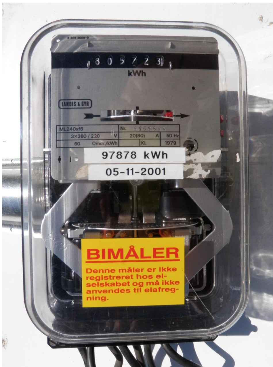
Figur 1. Elektromekanisk elmåler af Ferraris typen (fabrikat Landis & Gyr), set mod fronten. Lige over det gule mærkat ses den cirkulære metalskive, som bringes til at rotere, når den påvirkes af vekselfelterne fra to spoler. Igennem den ene spole (strømspolen) passerer strømmen, og over den anden spole (spændingsspolen) påtrykkes spændingen. Spolerne er arrangeret således, at skiven påvirkes samtidigt af de to vekslende magnetfelter stammende henholdsvis fra strømmen og fra spændingen. De to magnetfelter er naturligt faseforskudt 90°.
