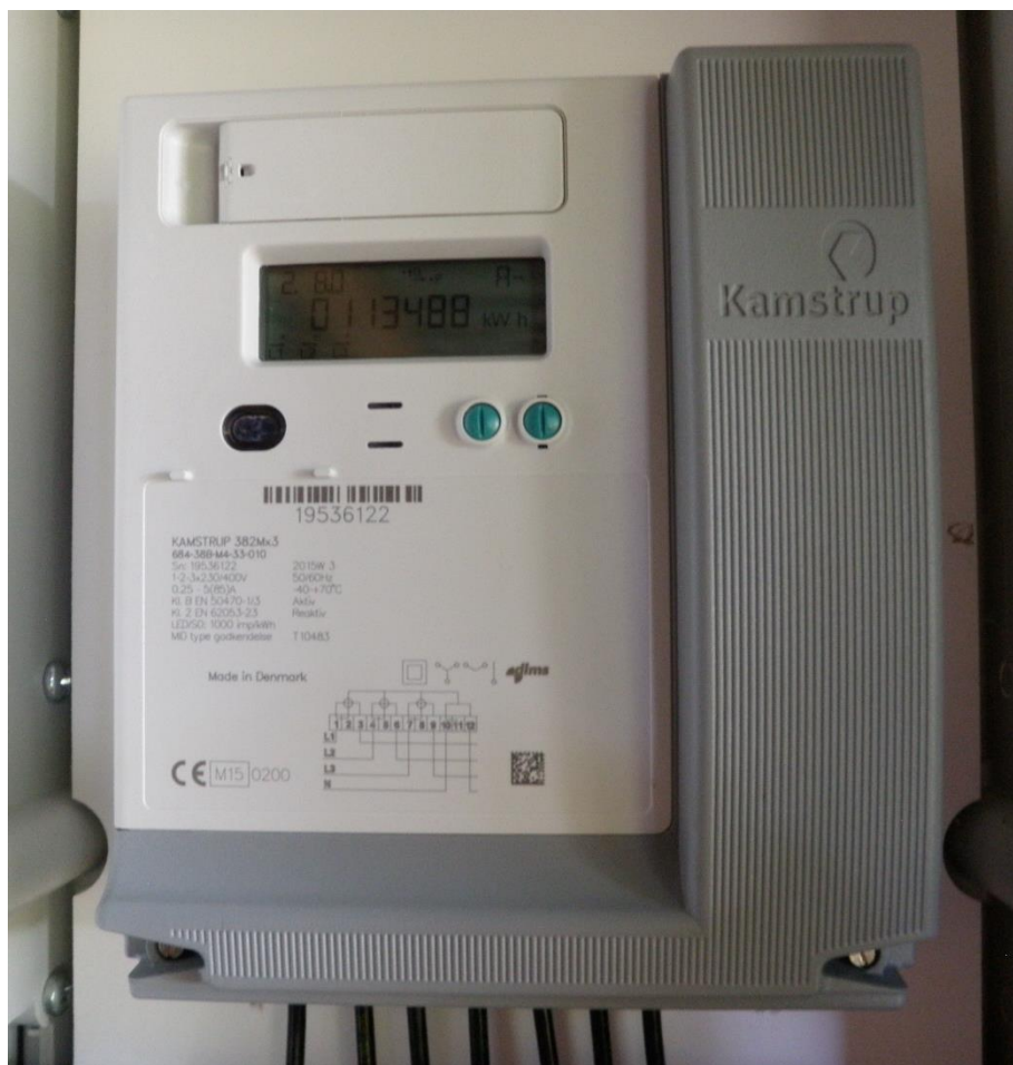
Figur 3. Statisk (fuldelektronisk) elmåler (fabrikat Kamstrup, model 382M). Ved at påvirke den venstre af knapperne under displayets højre side, kan man skifte mellem flere forskellige informationer på displayet. Nogle af displayvisningerne er opsummeret elforbrug fra tidspunktet for målertilslutning, aktuel effekt, triptæller for elforbrug og (som det faktisk vises her) opsummeret elproduktion. Denne elmåler befinder sig i kompendieforfatterens elinstallation, og i displayet vises den opsummerede elproduktion, som forfatterens husstandsvindmølle har leveret ud på elnettet siden tilslutningen. Alle data, som måleren registrerer, sendes via radioforbindelse (af samme type som mobiltelefonkommunikation) til elektricitetsselskabet til brug for afregningen.
