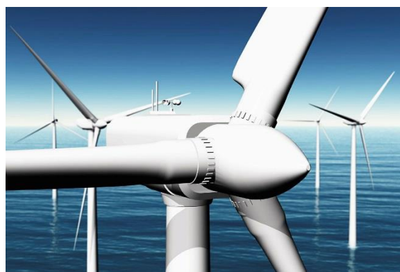
Figur 6: Vindhastighedsmåling på en nacelle.
